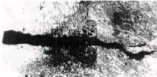
Рис. 4. Корозійне розтріскування зварних з'єднань трубопроводу
